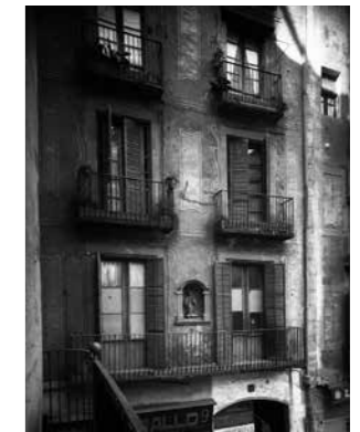
Balcons, al carrer de la Corribia, núm. 9, 1932. Mas IAAH.
