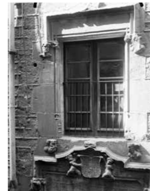
Finestra, al carrer del Governador (actual carrer de Duran i Bas), 1889-1916. AFCEC.
