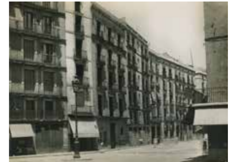
Edificis dels carrers del Bou de la Plaça Nova i de Sallent, buits per a ser enderrocats, vistos des de la placeta de la plaça Nova, 1944. Arxiu de l'AFP.
