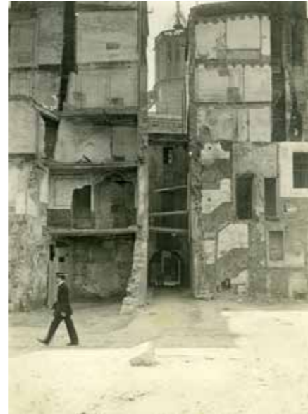
Enderroc al carrer de l'Arc de la Glòria, 1909-1911. Frederic Balcells Maymí, AFB.
