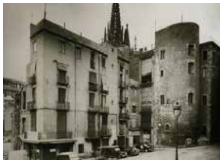
Darrers edificis de veïns al Racó de Sant Roc de la plaça Nova i enderroc al carrer de la Corribia, 1957. Arxiu Privat F. Closa Alegret, SA.
